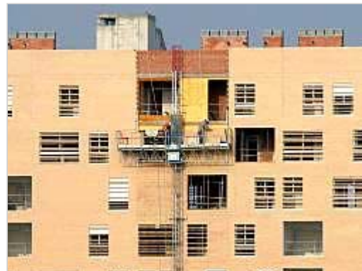
Edificio en construcción en Alicante.
